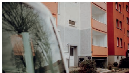
Dock W – Wohnung Außenansicht
