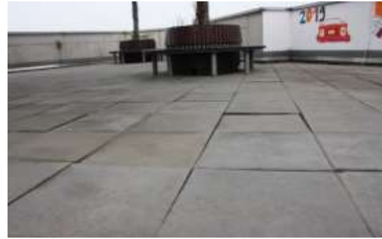
Abbildung 40: Bodenbelag aus Betonplatten auf dem Aufdach der WfbM 1.
