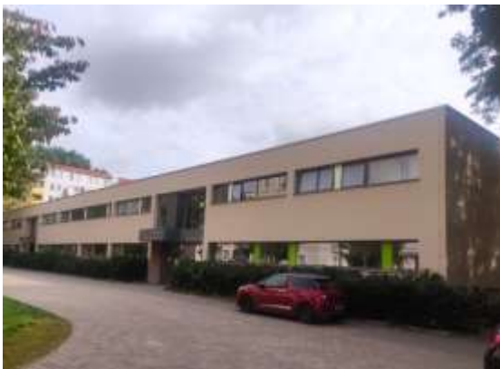
Abbildung 12: Standort BGZ in der Marchlewskistraße.
