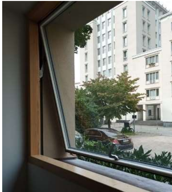
Abbildung 45: Nach außen geöffnetes Fenster.
