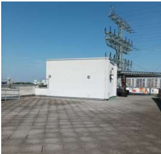
Abbildung 9: das Mitteldach der WfbM 1 mit Treppenhausaufgang.
