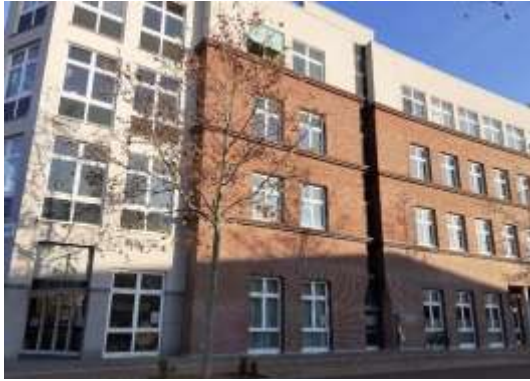
Abbildung 7: INTEGRAL-Gebäude am Standort Hermann-Blankenstein-Straße.
