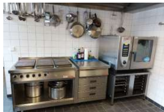
Abbildung 48: Küche im Begegnungszentrum.
