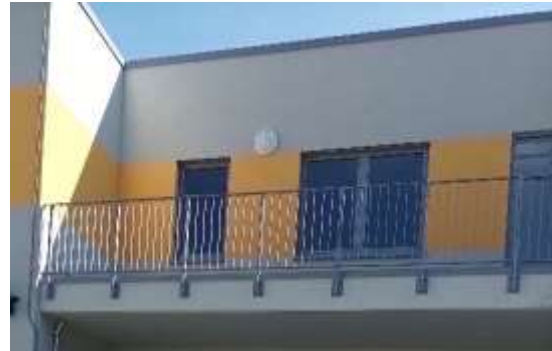
Abbildung 43: Balkon auf Nordwestseite.
