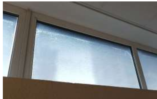
Abbildung 51: Oberlichter mit rissiger Hitzeschutzfolie.
