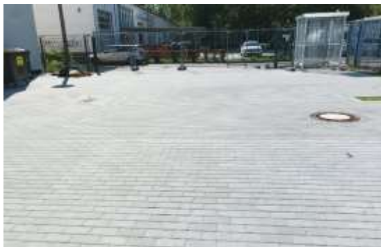
Abbildung 44: Gepflasterter Hofbereich Storkower Straße.
