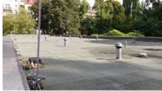
Abbildung 49: Dachfläche des BGZ.
