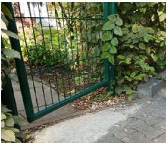
Abbildung 39: Gartenpforte zum Außenbereich des Förder- und Beschäftigungsbereichs, Gefahr des Überfließens der Schwelle bei Starkregen.
